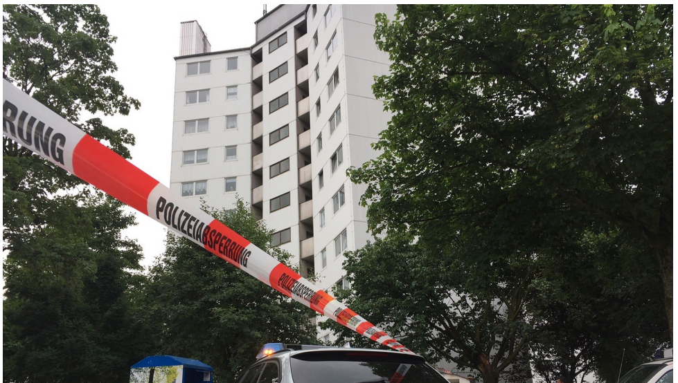
Hochhaus in Wuppertal mit ähnlich gefährlicher Wärmedämmung wie in London
